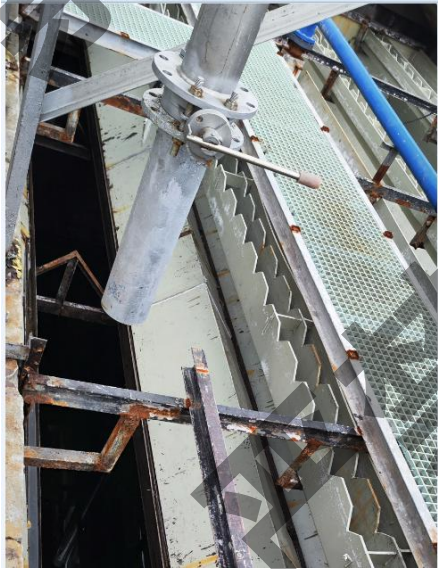
废水厌氧池已拆除
