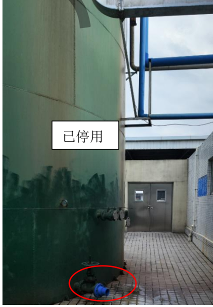
UASB 反应器 (厌氧塔) 已拆除废水管道
